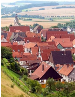
Blick auf Schwalenberg. Foto: D. Sondermann
